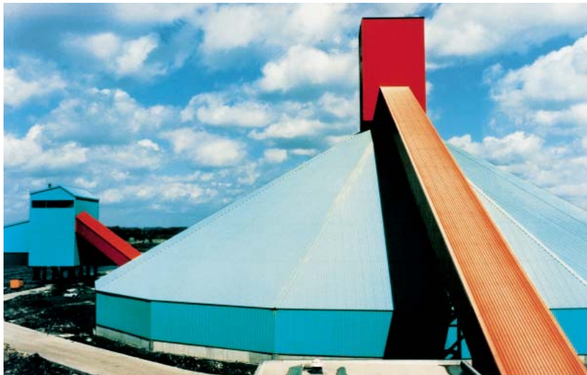
自動ディスチャージシステムを備えた囲いのある貯蔵ホール
