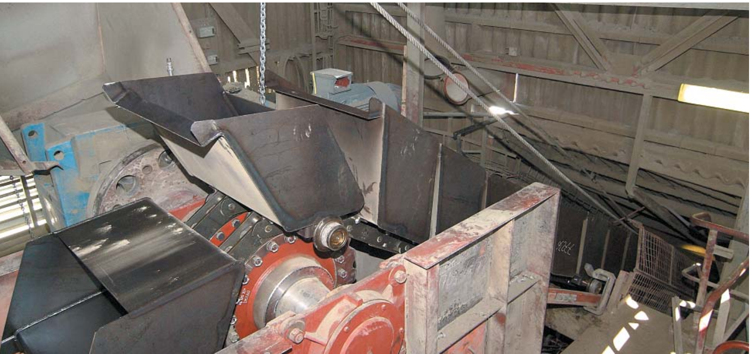
新しいバケットの据え付け
