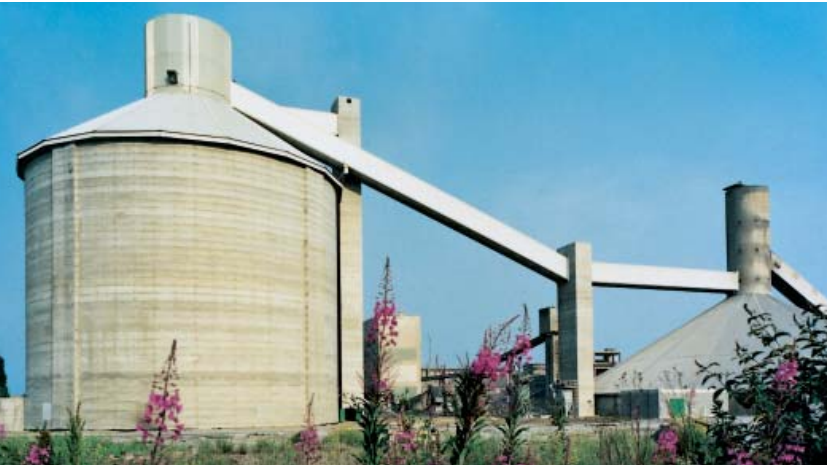
鋼製ルーフを持つコンクリート製サイロ
