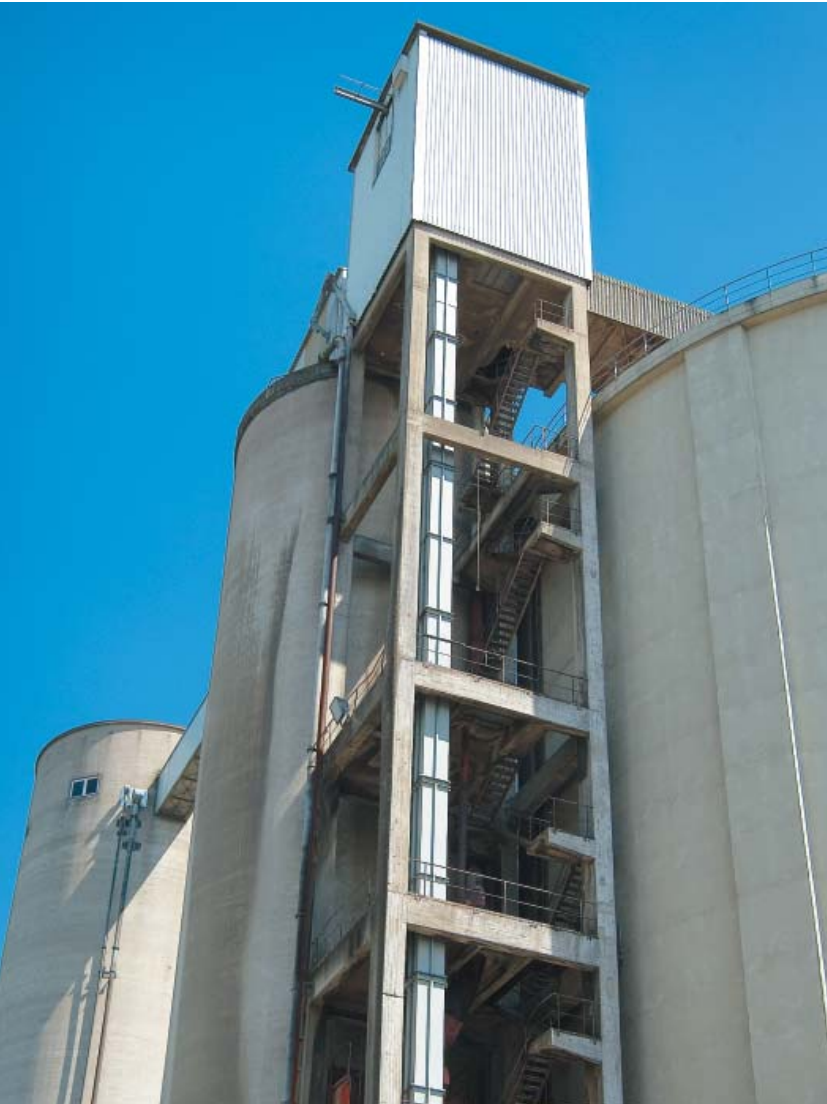
サイロ供給用のバケットエレベーター
