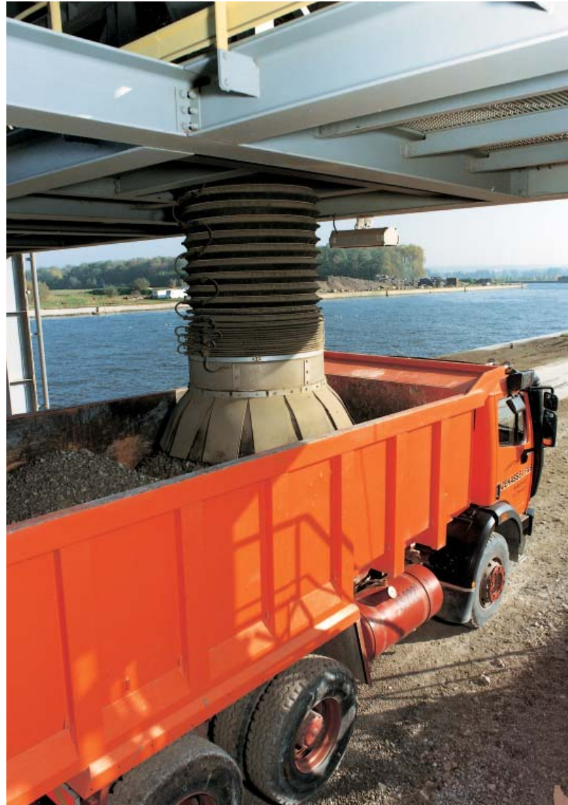
トラックへの積み込み
